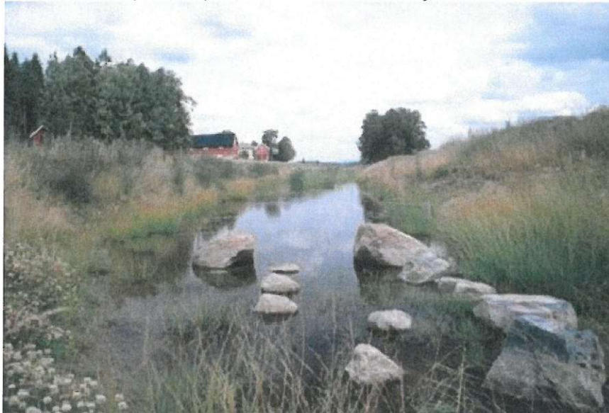
Bilde 5. Eksempelbilde på hvordan en sedimentasjonsdam kan se ut etter en tids bruk.
